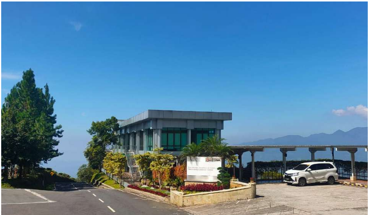
Gedung Geothermal Science Center - Star Energy sebagai sarana untuk menumbuhkan pengetahuan publik tentang proses dan manfaat panas bumi bagi kehidupan
