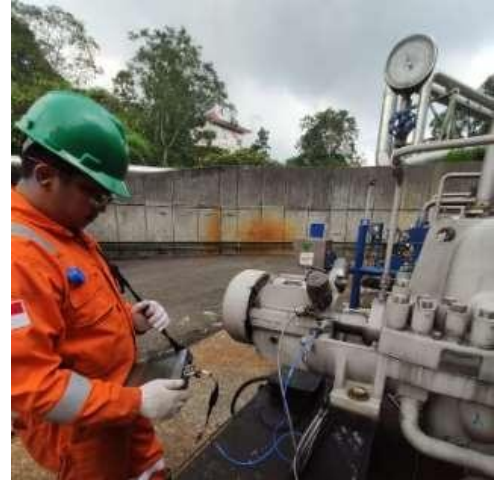
Gambar D2. Monitoring Menggunakan Alat Vibrasi
